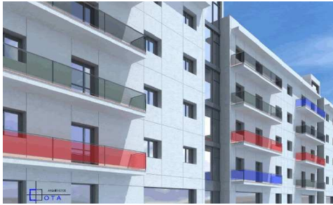
ICS, fachada de un edificio básico del Sistema Automático de Edificación
