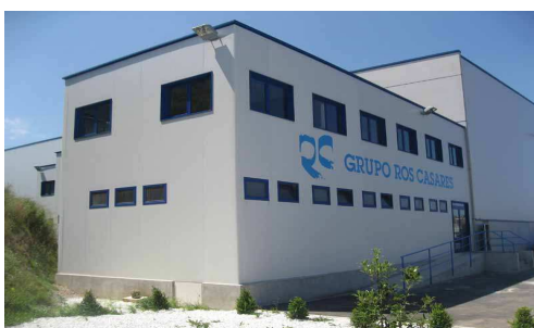
Edificación de Meltec
