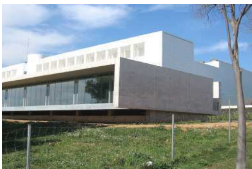
57 viviendas en Campus UPC de Sant Cugat del Valles de Compact Habit
