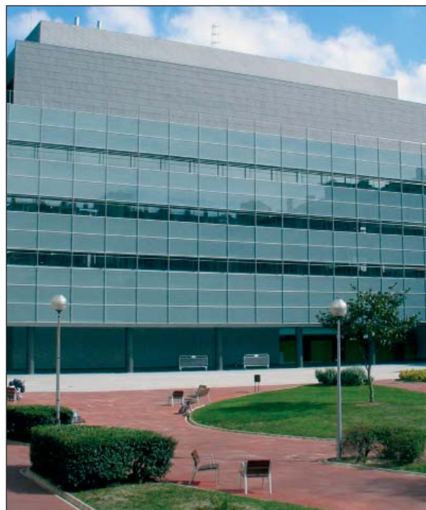
Centro Cultural Leioa. Bizkaia. Obra del 2002 al 2004: Insonorización, protección contra incendios, sistemas constructivos a base de cartón-yeso y suministro
