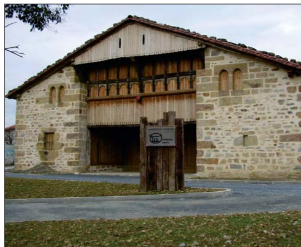
Reforma del caserío Landetxo Goikoa. Ayuntamiento de Mungia. Bizkaia
