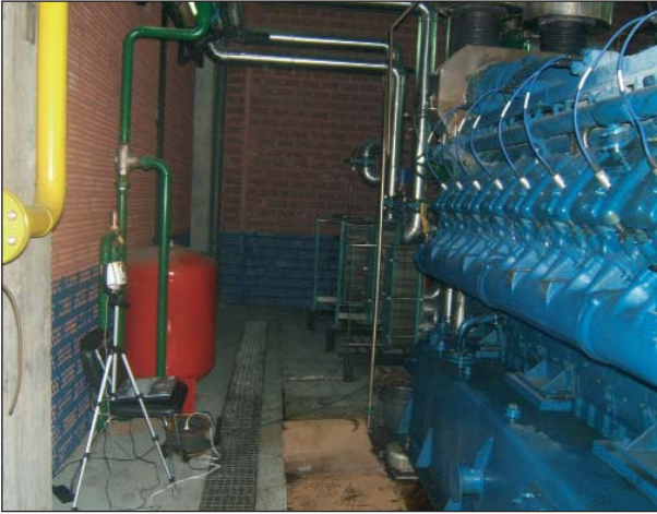
Inspección con cámara termográfica de los pistones del motor Deutz TCG2020V20 de Cogeneración Bergara AIE
