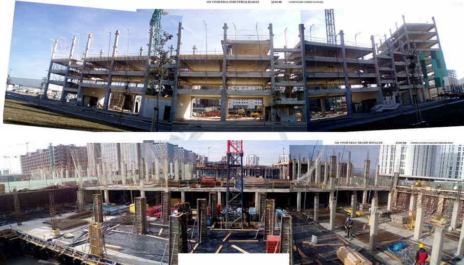
156 Viviendas Industrializadas en Zabalgana
