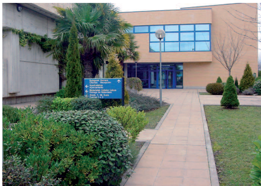
Laboratorio de Control de Calidad de la Edificación del Gobierno Vasco
