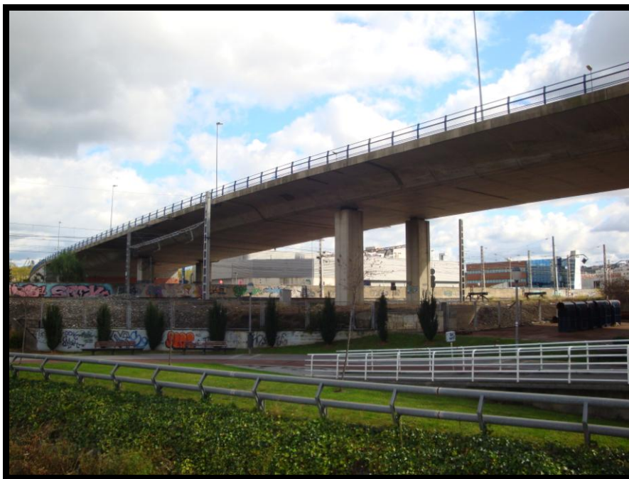
31. Viaducto sobre las vías del F.F.C.C.
