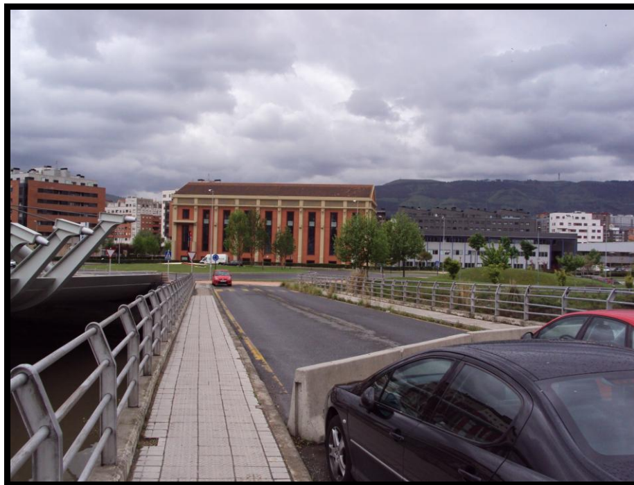
2. Puente sobre el río Galindo en desuso
