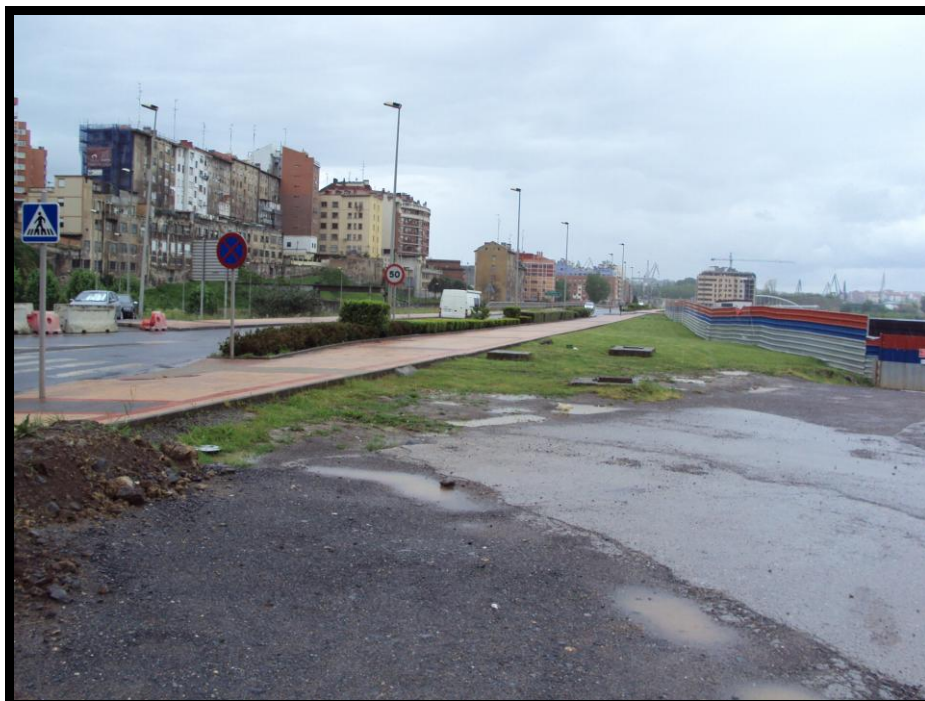
4. Tramo final de la Avenida de Altos Hornos
