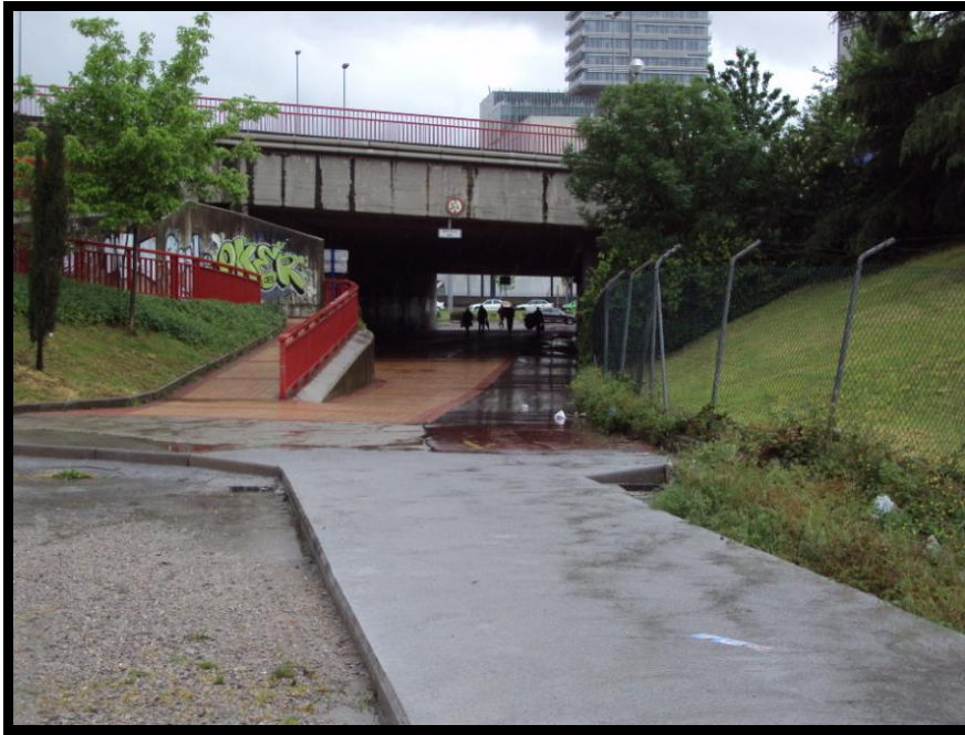
9. Paso inferior existente bajo la N-637 y pasarela a sustituir
