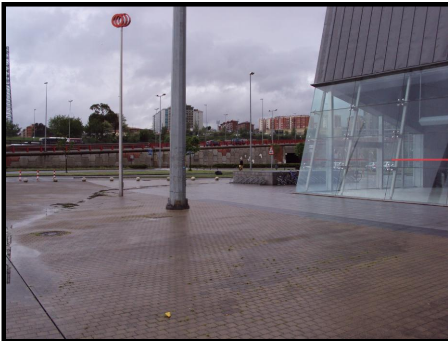
10. Emplazamiento de la parada de Ansio junto a la estación de Metro del B.E.C.
