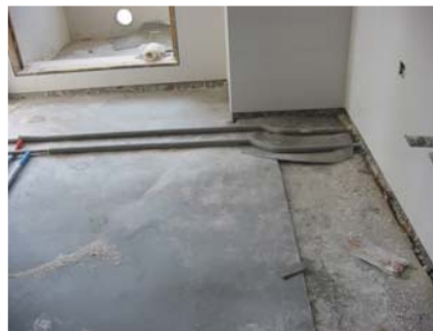
Proceso colocación material anti-impacto
