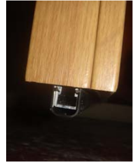
Hoja de puerta con sistema de guillotina
