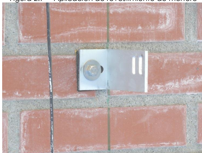
Figura 2.10 – Anclaje atornillado sobre el ladrillo caravista
