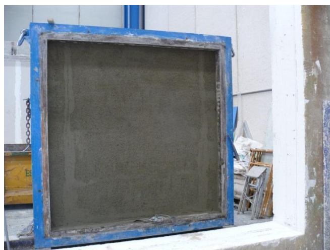
Figura 2.5 – Construcción de la muestra: muro de doble hoja de fábrica de ladrillo
