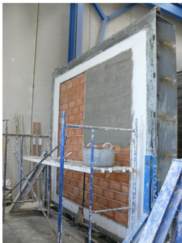
Figura 2.9 – Aplicación de revestimiento de mortero
